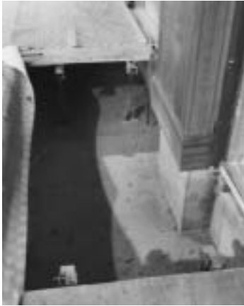
写真11 ベタ基礎と柱の打ち増し部分
