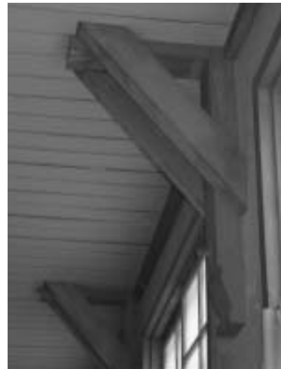
写真7 天井を支える付け柱
