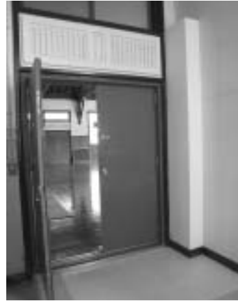
写真12 更衣室の柱の打ち増し部分
