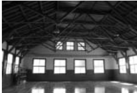
写真9 改修中の屋内東面
