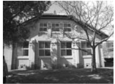
写真8 「武道場」東立面
