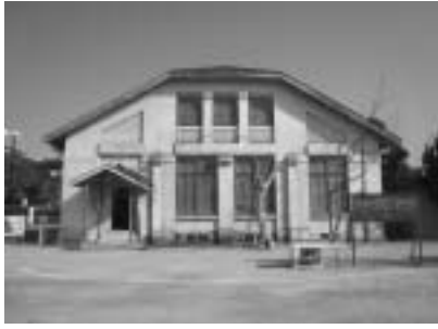
写真1 「武道場」南立面
