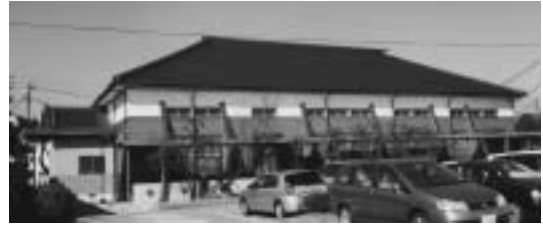
写真13 「武道場」東立面
