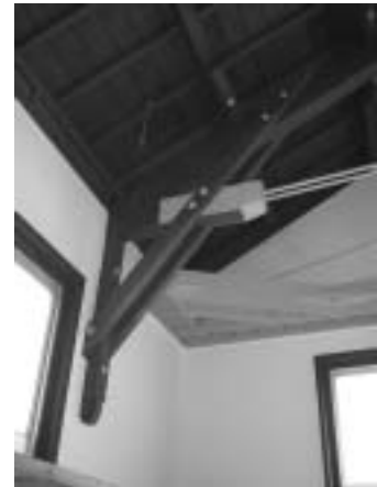
写真10 付け柱と裏面に付設した水平ビーム
