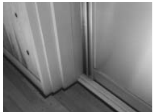
写真16 添柱により増加した壁厚
