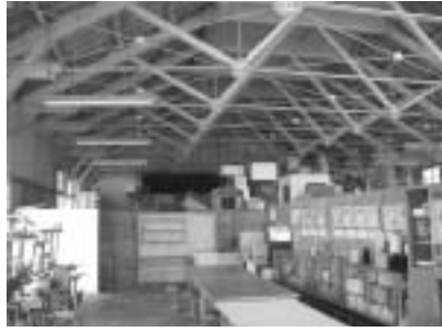
写真2 屋内のトラス
