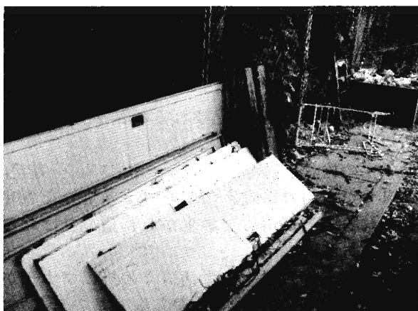
外されて放置されていたロッカーのドア
