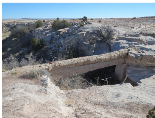
図 8. Agate Bridge. 崩落しないようにコンクリートで支えられている。
