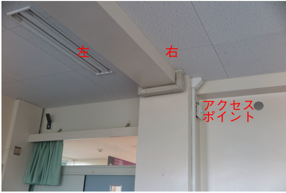
図10：306教室の天井の梁
