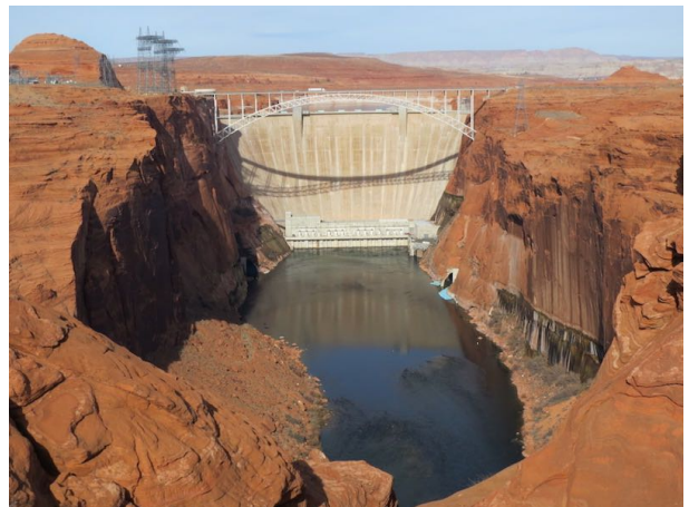
図 18 グレンキャニオンダム。コロラド川をせき止めてパウエル湖（Lake Powell）をつくっている。ダム手前のアーチ橋は国道 89 号線。
