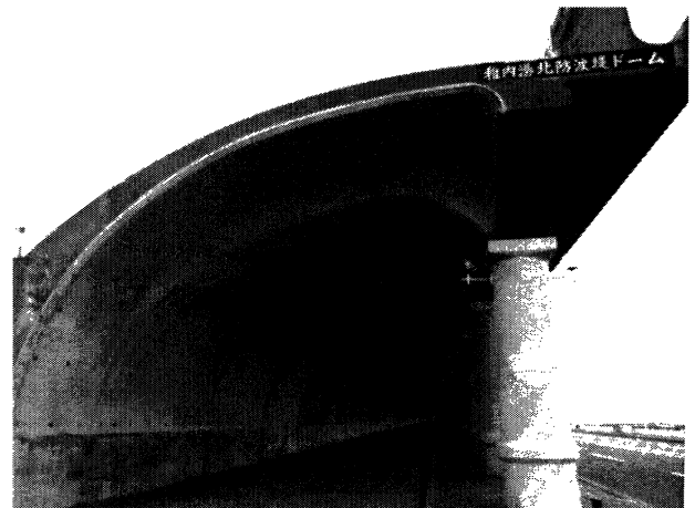
写真1 稚内港北防波堤ドーム
