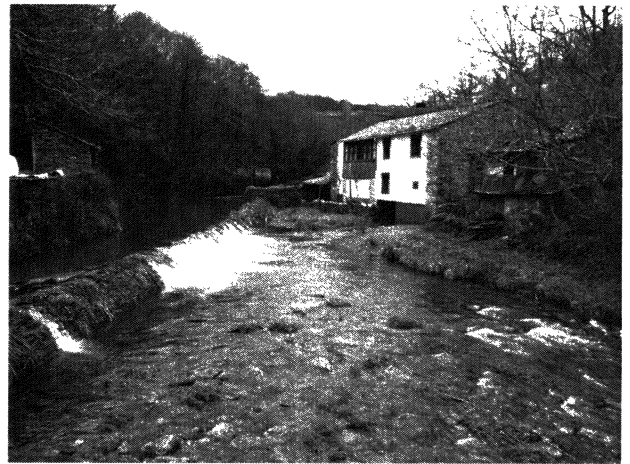
写真6 巡礼路沿いに立つ水車小屋
