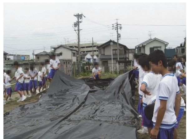
図8 防水シート敷き (6月3日)
