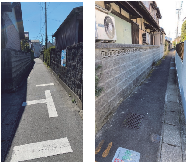
写真(左): 道路の両側に位置するブロック塀 写真(右): 幅員の狭い道路に位置するブロック塀 (いずれも2020年11月10日、筆者撮影)
