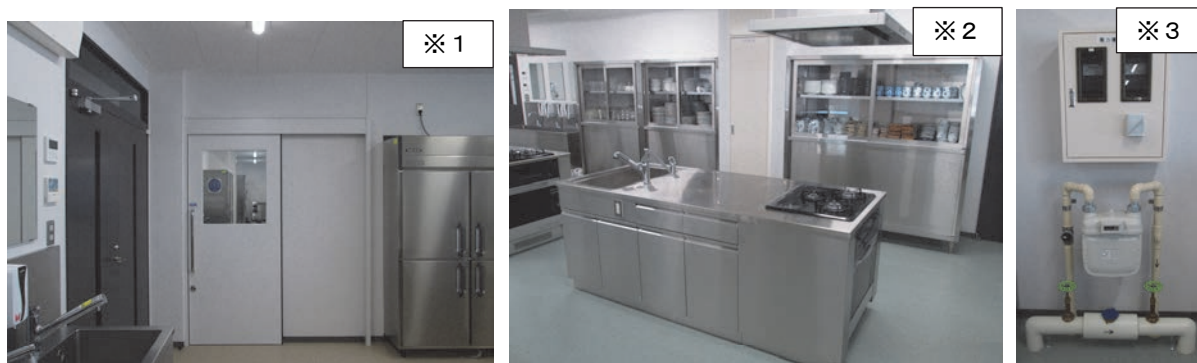
図 4 パススルー冷凍冷蔵庫、学生用調理台（ビルドイン型ガスコンロ付き）、ガス・水道の大元栓の写真 (※1、※2、※3：図3の撮影場所から)
